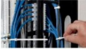
Der Twist Tail™ ist schnell und einfach an Leitungen zu installieren. Das Binderende wird sauber abgebrochen, ohne ein spezielles Werkzeug und verhindert so ernste Verletzungen.
